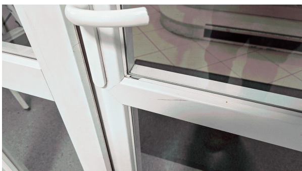
Prélèvement - P78 : RDC / Z1 - Accueil - Joint de vitrage- (Absence d'amiante)
