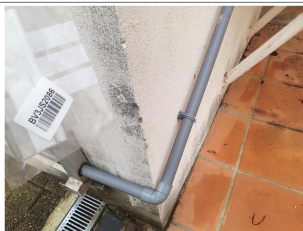
Prélèvement - P47 : Extérieur / Façade - Enduit- (Absence d'amiante)
