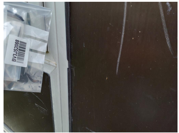
Prélèvement - P49 : Extérieur / Façade - Joint de vitrage- (Absence d'amiante)
