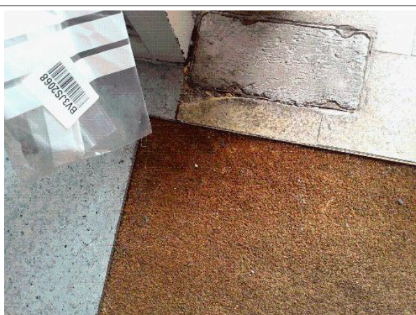
Prélèvement - P29 : RDC / Z7 - Bureaux - Chape maigre- (Absence d'amiante)
