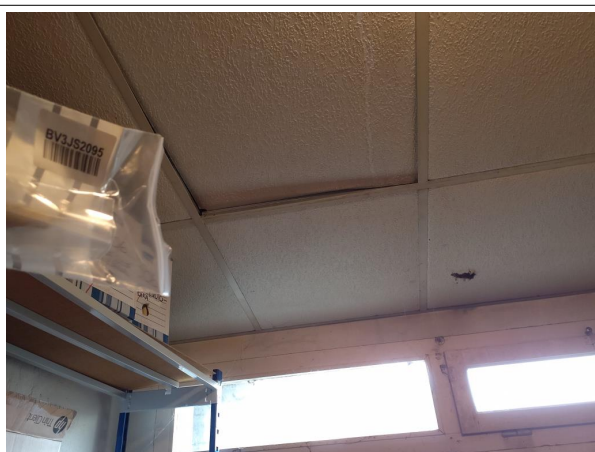
Prélèvement - P56 : RDC / Z9 - Archives - Faux plafond- (Absence d'amiante)
