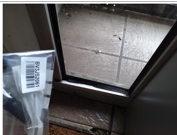
Prélèvement - P22 : RDC / Z1 - Accueil - Joint de vitrage- (Absence d'amiante)
