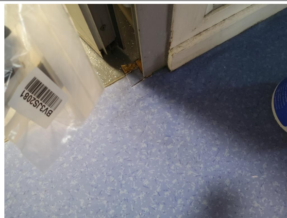
Prélèvement - P42 : RDC / Z4 - Archives - Lé plastique- (Absence d'amiante)
