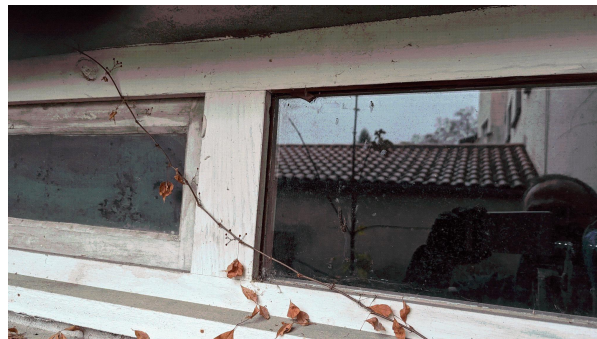
Prélèvement - P75 : Extérieur / Façade - Joint de vitrage- (Absence d'amiante)
