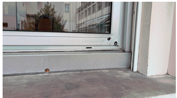
Prélèvement - P65 : Extérieur / Façade - Revêtement dur- (Absence d'amiante)
