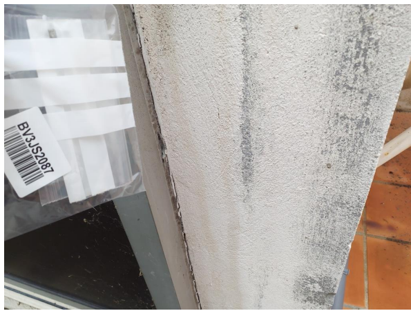
Prélèvement - P48 : Extérieur / Façade - Joint- (Présence d'amiante)
