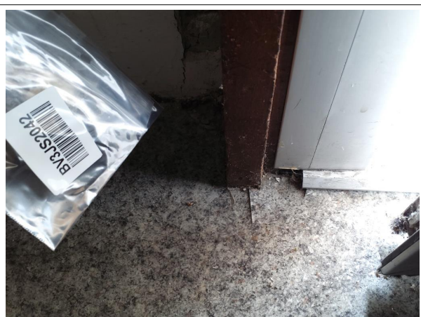
Prélèvement - P3 : RDC / Z11 - Bureaux - Lé plastique- (Absence d'amiante)
