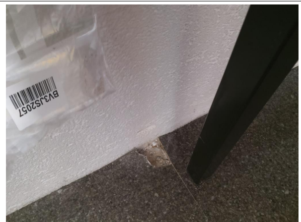
Prélèvement - P18 : RDC / Z3 - Bureau - Enduit- (Absence d'amiante)
