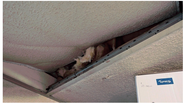
Prélèvement - P71 : RDC / Z9 - Archives - Isolant- (Absence d'amiante)
