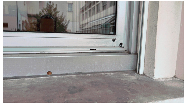
Prélèvement - P69 : Extérieur / Façade - Joint de vitrage- (Absence d'amiante)
