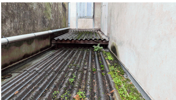
Prélèvement - P76 : Extérieur / Toiture - Plaque ondulée- (Présence d'amiante)
