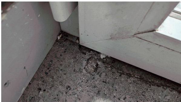
Prélèvement - P80 : RDC / Z1 - Accueil - Lé plastique- (Absence d'amiante)
