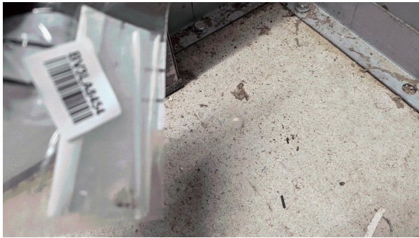
Prélèvement - P70 : RDC / Z13 - Coffre - Chape maigre- (Absence d'amiante)
