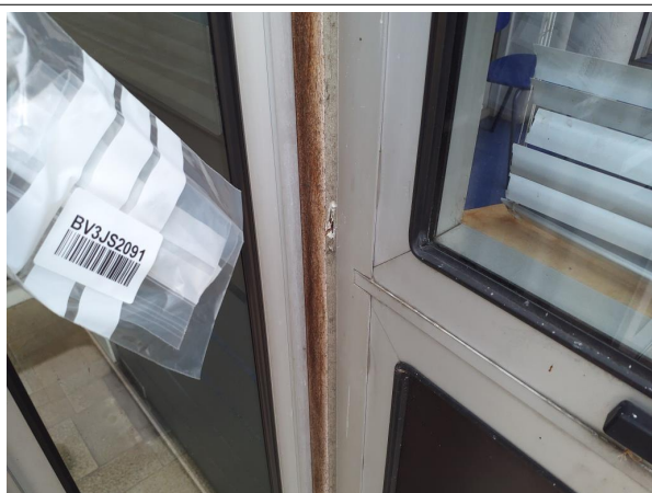
Prélèvement - P52 : Extérieur / Façade - Joint- (Présence d'amiante)
