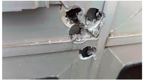
Prélèvement - P61 : Extérieur / Façade - Joint- (Présence d'amiante)
