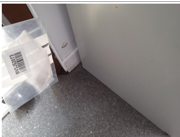
Prélèvement - P34 : RDC / Z7 - Bureaux - Panneau- (Absence d'amiante)
