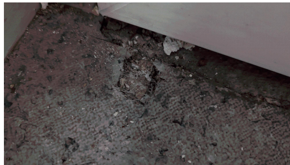
Prélèvement - P81 : RDC / Z1 - Accueil - Ragréage- (Absence d'amiante)
