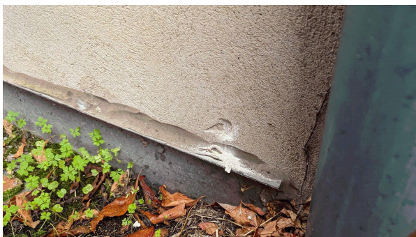
Prélèvement - P72 : Extérieur / Façade - Enduit- (Absence d'amiante)
