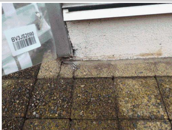
Prélèvement - P50 : Extérieur / Façade - Joint de vitrage- (Absence d'amiante)
