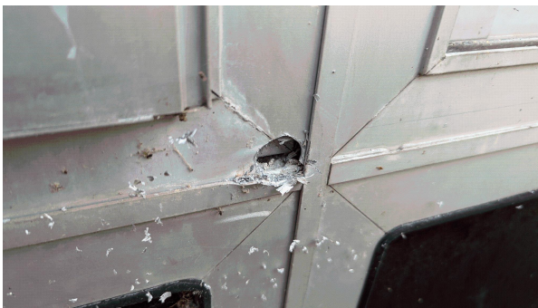
Prélèvement - P62 : Extérieur / Façade - Joint- (Présence d'amiante)
