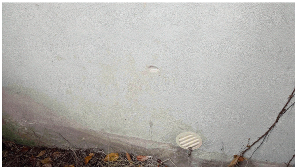
Prélèvement - P74 : Extérieur / Façade - Enduit- (Absence d'amiante)
