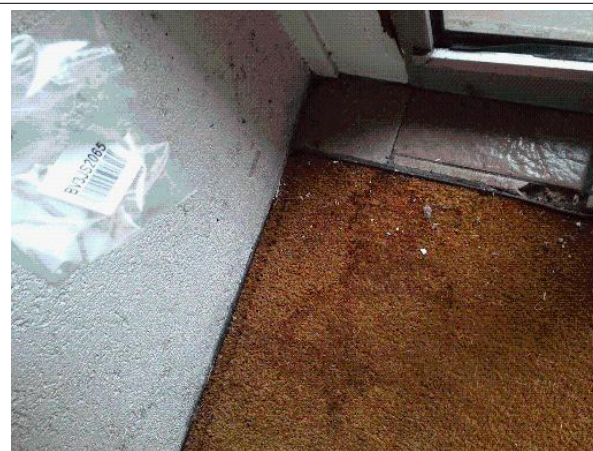
Prélèvement - P26 : RDC / Z1 - Accueil - Enduit- (Absence d'amiante)
