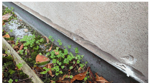
Prélèvement - P73 : Extérieur / Toiture - Joint- (Absence d'amiante)
