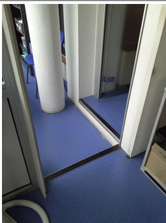
Prélèvement - P39 : RDC / Z6 - Bureaux - Nez de marche- (Présence d'amiante)
