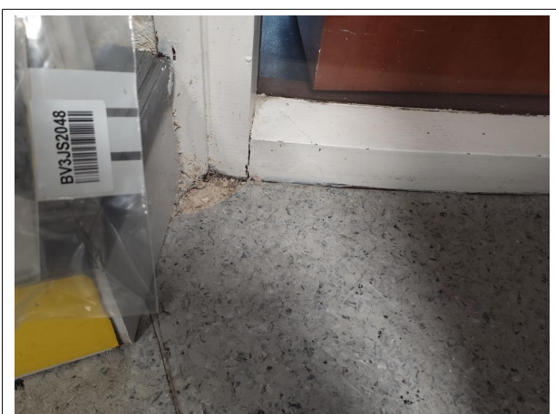
Prélèvement - P9 : RDC / Z1 - Accueil - Lé plastique- (Absence d'amiante)
