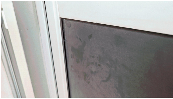
Prélèvement - P68 : Extérieur / Façade - Joint de vitrage- (Absence d'amiante)
