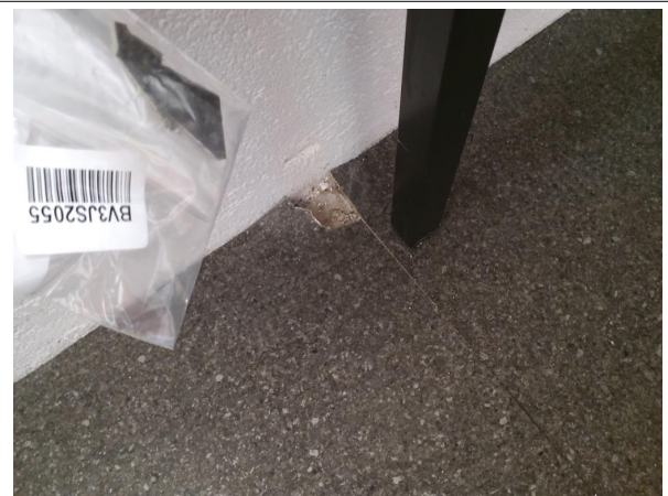
Prélèvement - P16 : RDC / Z3 - Bureau - Lé plastique- (Absence d'amiante)
